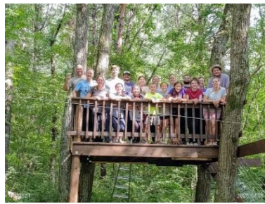
ツリーデッキ完成
